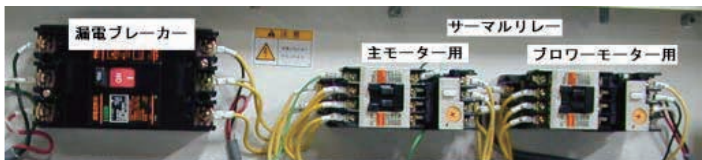
2-7 主モーター用サーマルリレー (スーパーセトル60DX)
